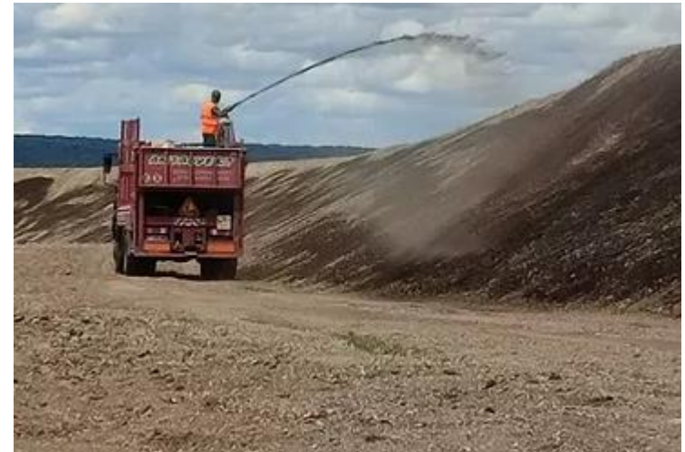
Apport de compost et semis du merlon par méthode hydroseeding
