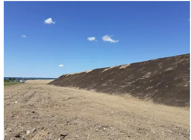
Apport de compost et semis du merlon par méthode hydroseeding
